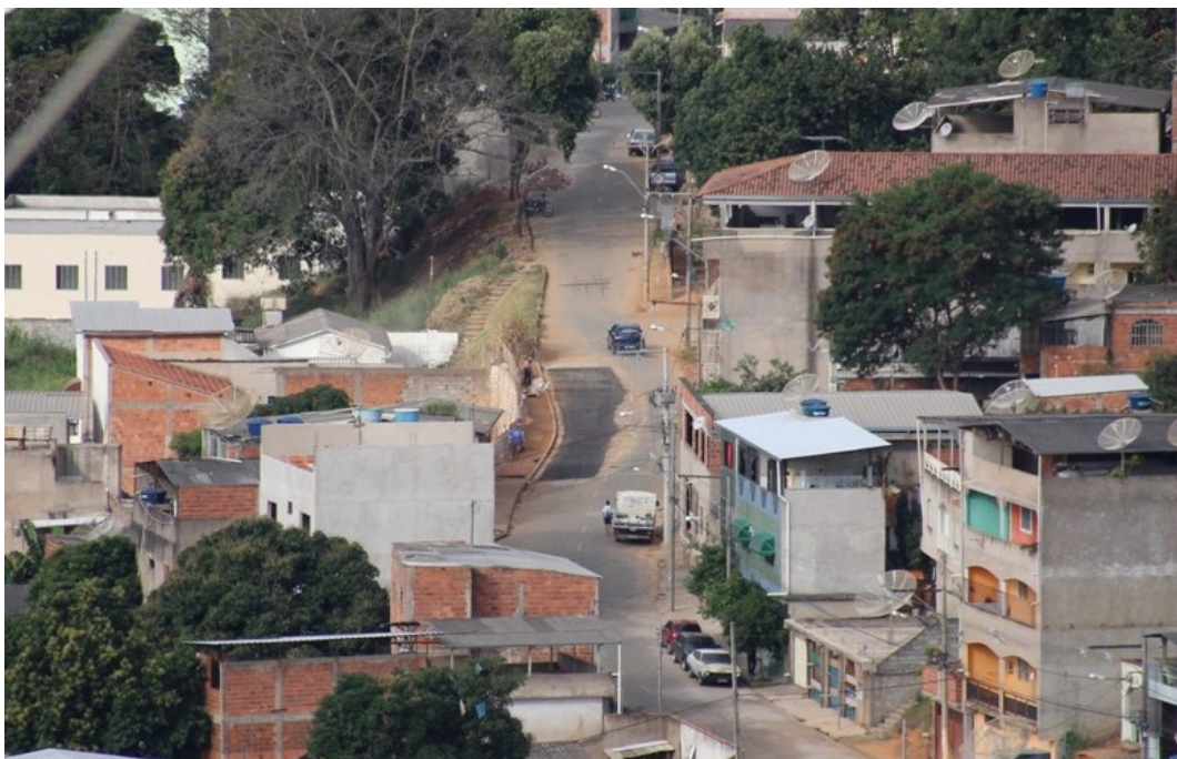
A Prefeitura executou as obras de recuperação da Rua Quetúnia, que foi entregue à comunidade este mês
