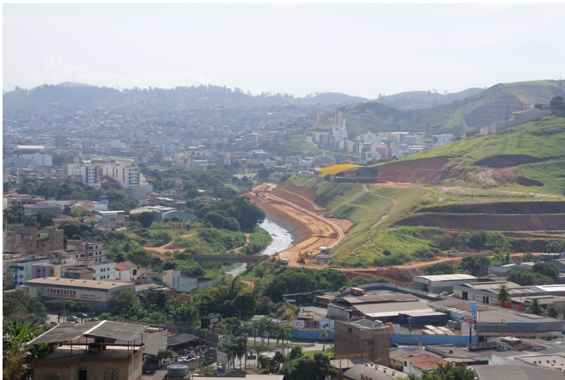
As obras na Avenida Maanaim seguem em ritmo normal e já se destacam na cidade
